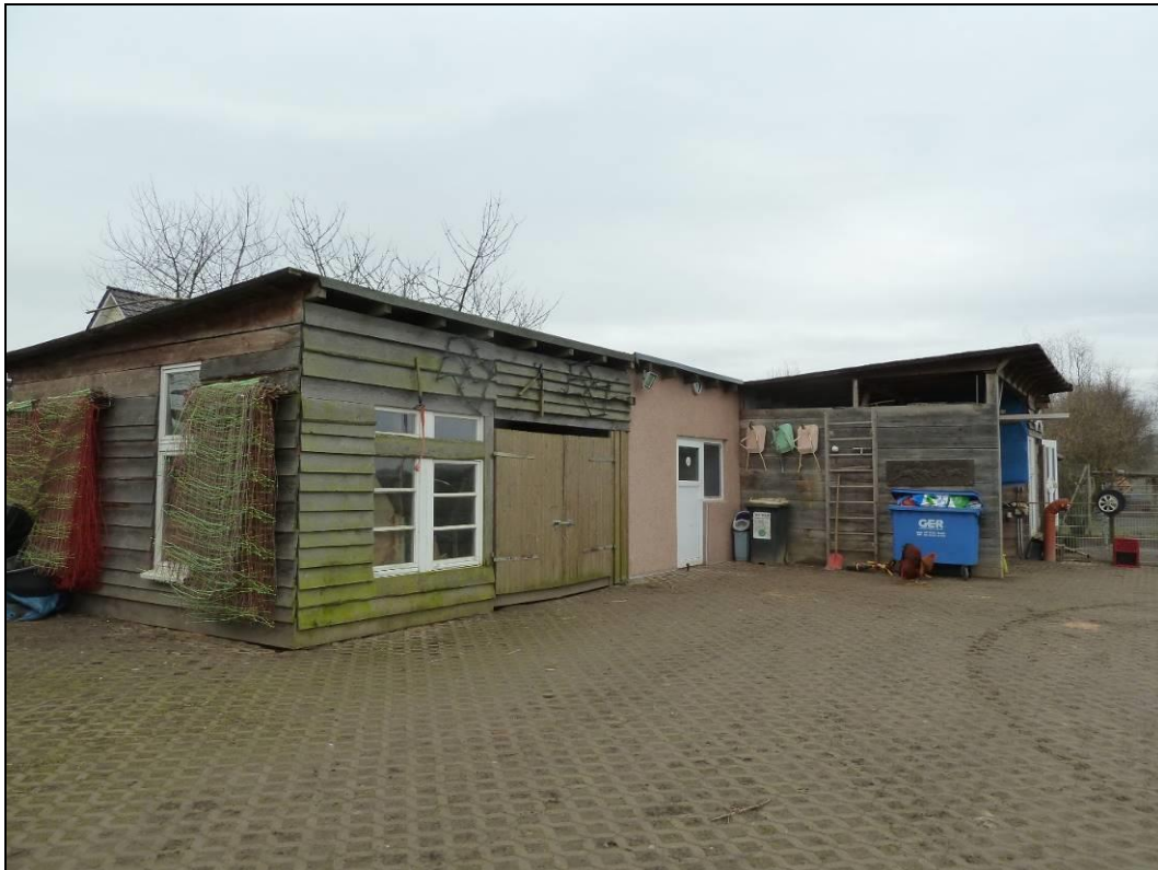
Abbildung 6: Nebengebäude in den Freianlagen.
