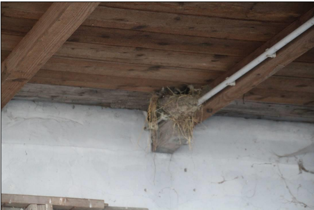
Abbildung 10: Nest der Rauchschnalbe mit Spuren der Nachnutzung durch den Haussperling an einem Nebengebäude innerhalb des Plangeltungsbereiches.
